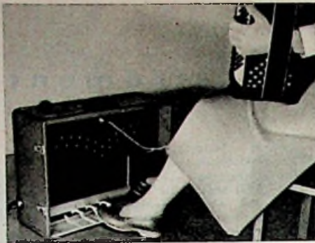
Oszillatorkoffer mit Schalteinrichtung der Hohner „Vox“, einer Kombination eines normalen Akkordeons mit einem monophonen Hohner-„Electronium“
